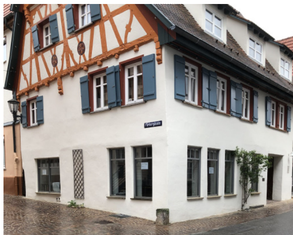
Das neue „ABW-Büro“ befindet sich im Erdgeschoss dieses Gebäudes in der Münsinger Innenstadt
