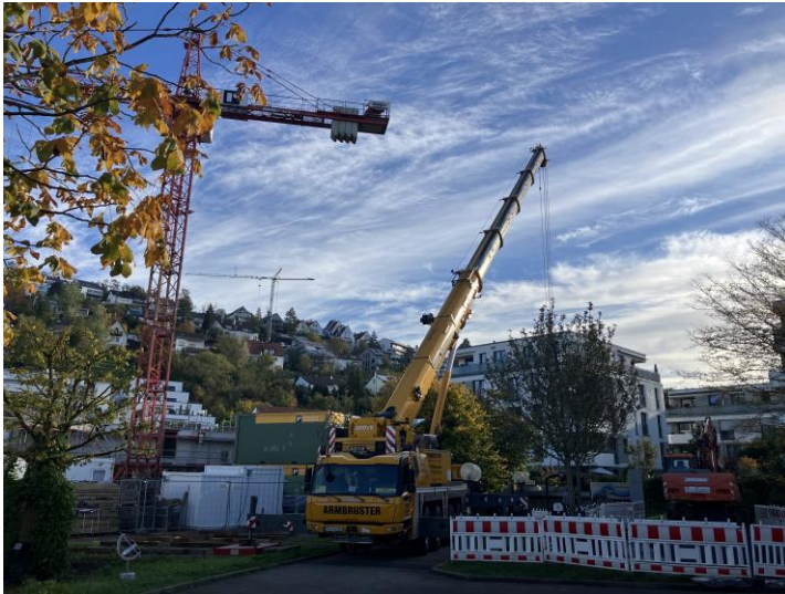
Der Tank kommt
