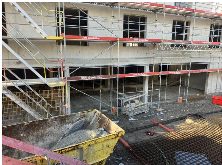
Tiefgarage und Pflegedienst sind fertig
