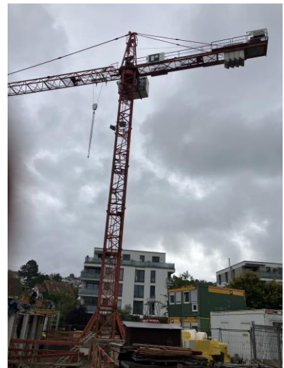
Arbeit in luftiger Höhe
