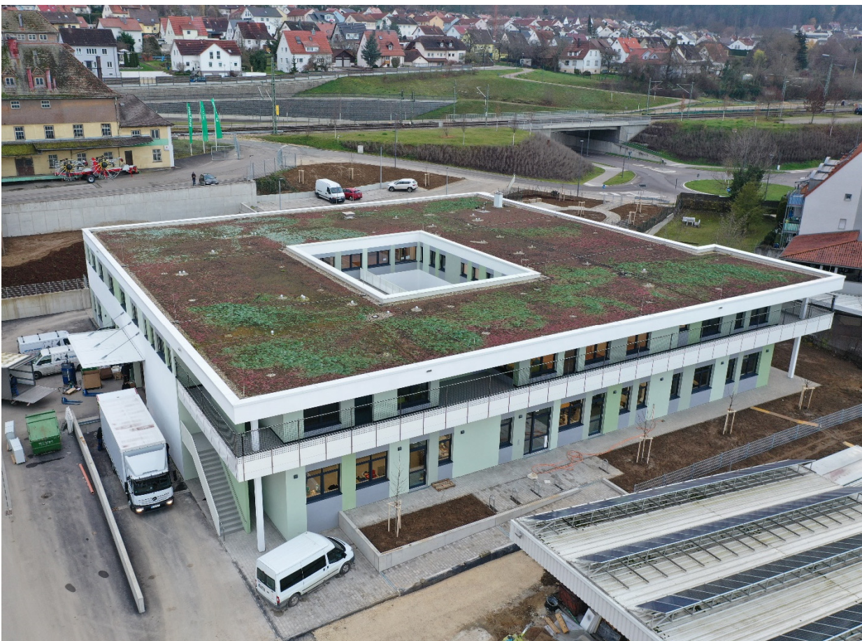
Der Neubau der Werkstatt am Ipf in Bopfingen
